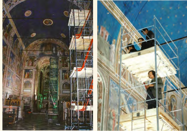
▲【写真2】 礼拝堂に建てられた高さ12メートルの足場。 壁画と同じ目線に立つことで詳細な調査ができた。
