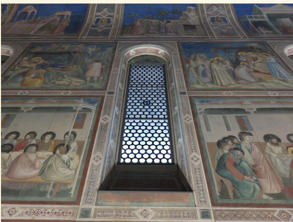
▲【写真3】窓枠内側はテラコッタで製作。窓枠外の支えはひずみ防止、施工現場で役立っている。
